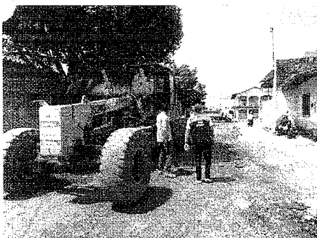
Secretário Zigomar Filho vistoria frente de serviço de regularização da rua Santo Cristo, no bairro Nova Imperatriz
