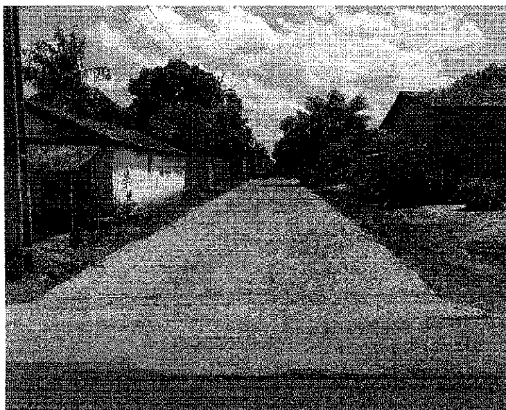
Figura 13. RUA 13 DE MAIO COORDENADAS (x=273094, y=9284609).
