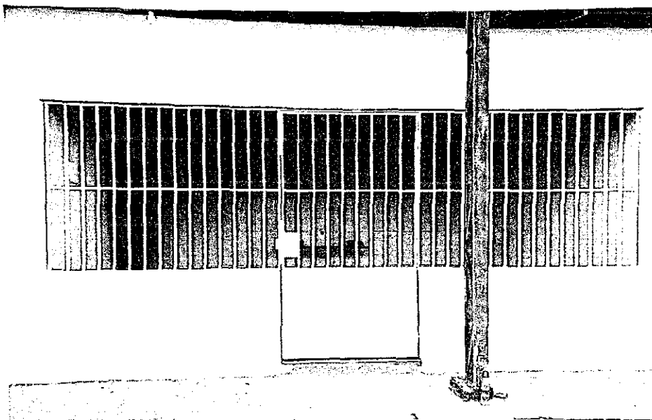
FOTO 08: VISTA DA ENTRADA DA COZINHA, PRÉDIO DA GUARDA MUNICIPAL, MUNICIPIO DE GRAJAÚ/MA.
